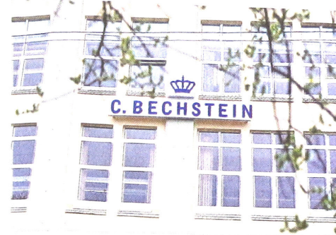
Zur neuen Fassadengestaltung gehört nun auch eine Leuchtreklame.
